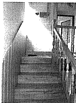
Schody do podkrovia
