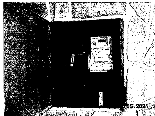
Rozvádzač a elekromer na fasáde domu
