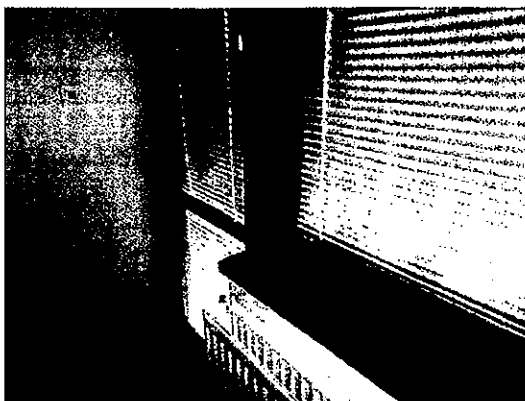
Detail okna v podkroví
