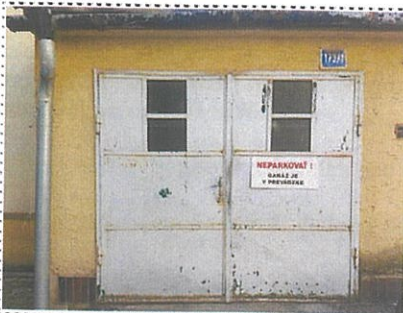
Garáž súp. č. 100173
