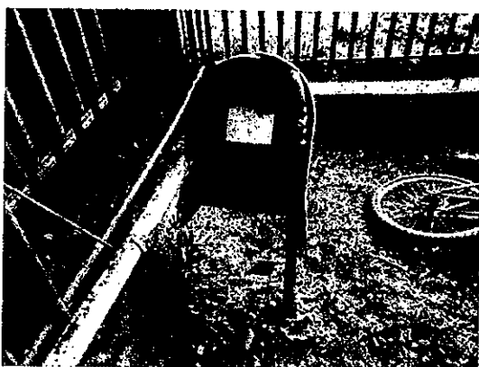
Plynomerná skrinka bez plynomeru
