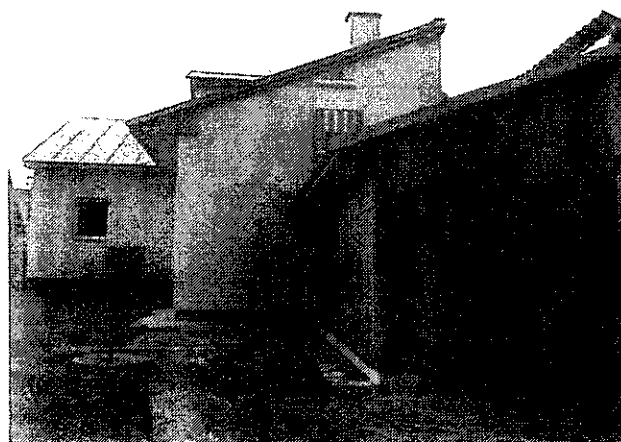
Rodinný dom s.č.1799,p.č.3742/1 a sklad s prístreš.p.č.3743/1 Lučenec, Ul.Podjavorinskej č.1799/11- pohľad S zo záhrady
