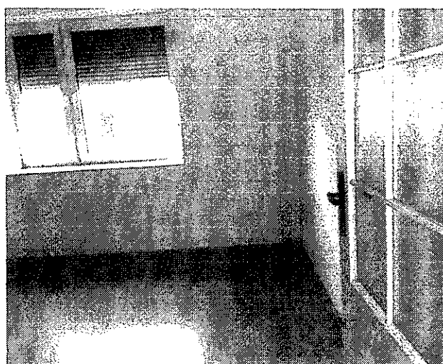
Rodinný dom s.č.1799,p.č.3742/1,Ul.Podjavorinskej č.1799/11 Lučenec, I.NP - izba
