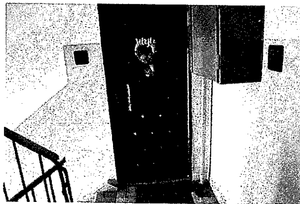
Vchodové dvere do bytu č.4 na 2.p.
