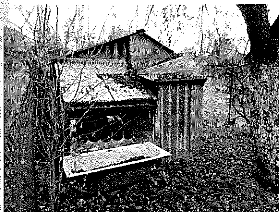
Vedľajšia neidentifikovaná stavba na pozemku
