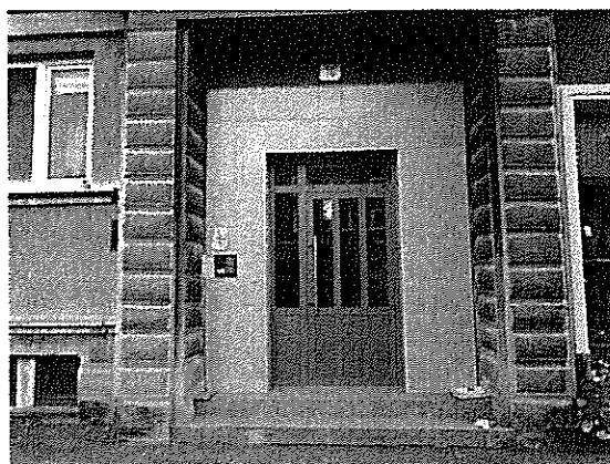
Pohľad na vchod č. 10 zo západnej strany
