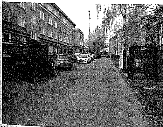
Komunikácia na východnej strane domu
