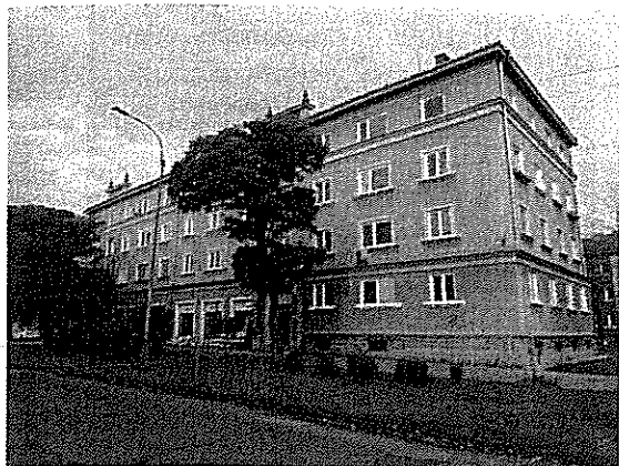
Pohľad na bytový dom z JZ strany
