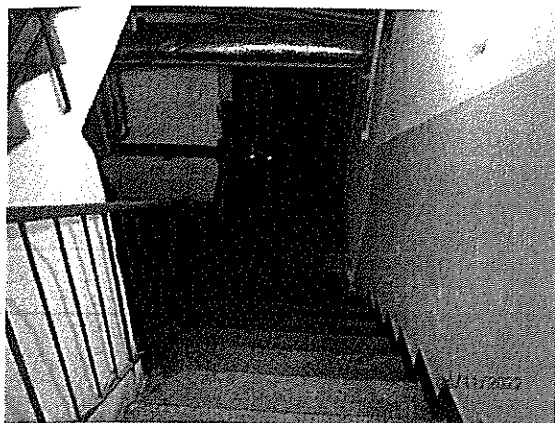
Schodisko do suterénu
