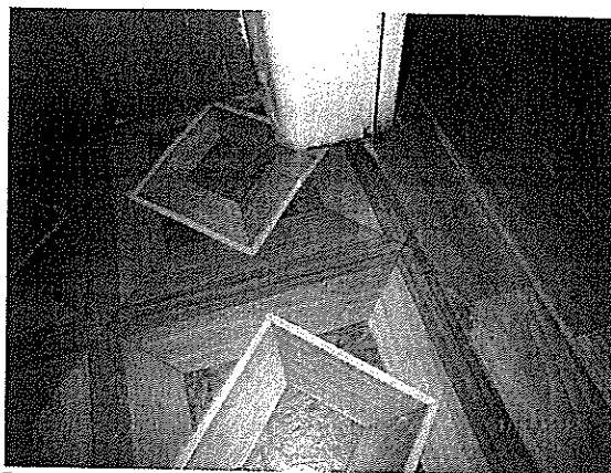
Detail podlahy izby č. 4 - PVC
