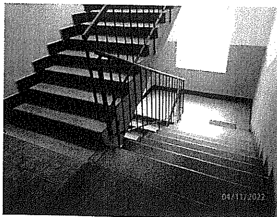
Schodisko v bytovom dome
