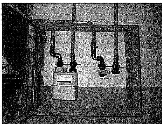
Plynomer pre byt č. 23 demontovaný
