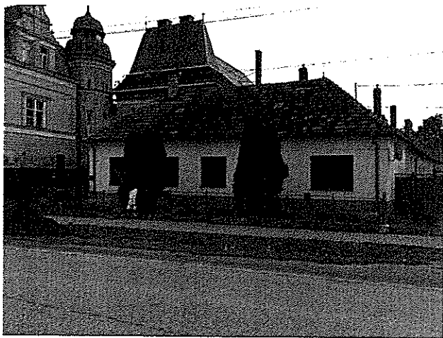
Pohľad od ulice
