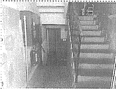
Schodisko a zádverie hl. vstupu
