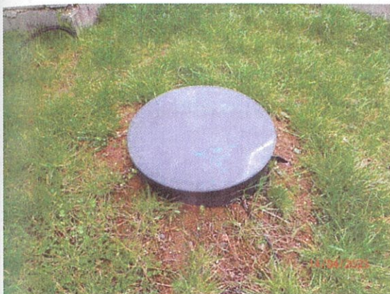
Vodomerňa šachta za domom
