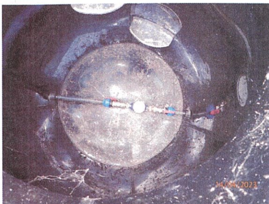
Pohľad do vodomernej šachty
