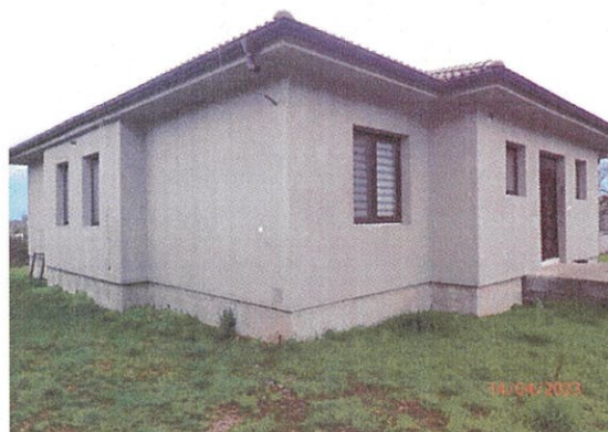
Pohľad na dom zo severnej strany
