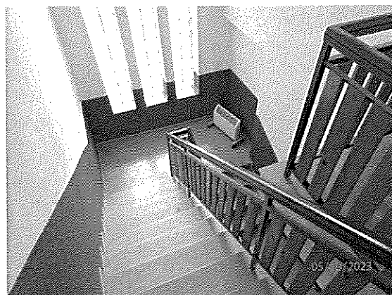
Schodisko na II.NP
