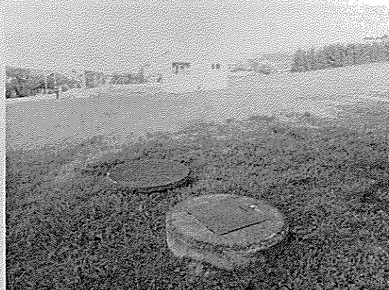
Studne na južnej strane na parc. 318/1
