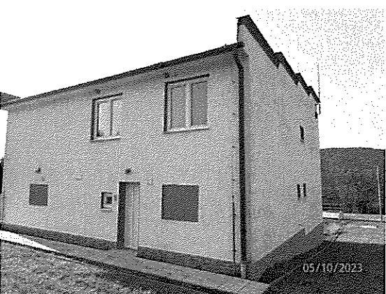
Pohľad na dom zo severnej strany
