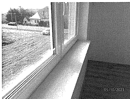
Detail okien v dome s izolačným trojsklom
