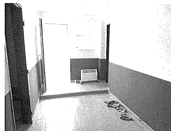
Vstup do domu zo SV strany
