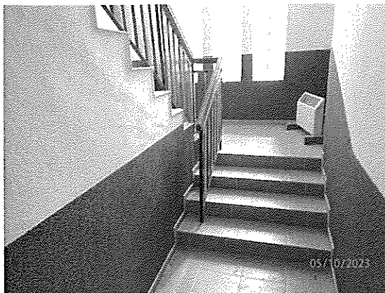
Schodisko na II.NP
