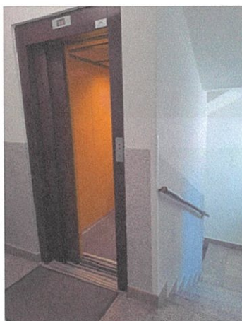
Spoločné priestory bytového domu
