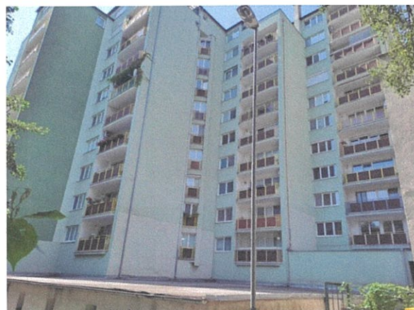
Pohľad z východnej strany
