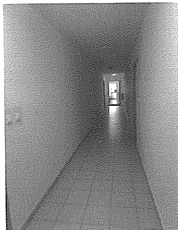
Spoločné priestory bytového domu
