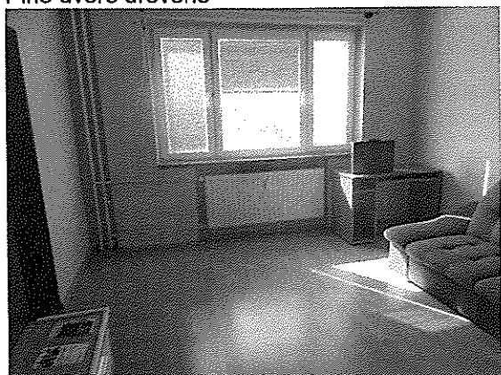
Izba –plávajúca podlaha, panelový radiátor, plastové okno
