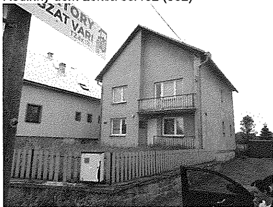
Čelný pohľad na RD Lokca
