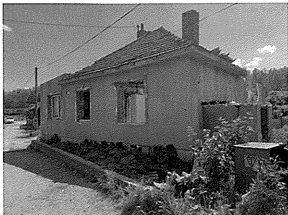
Pohľad na rodinný dom zo severnej strany
