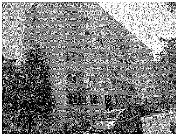
Pohľad na bytový dom zo západnej strany
