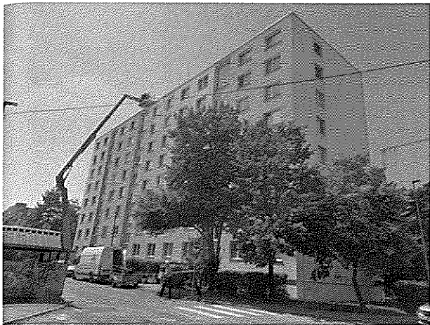
Pohľad na bytový dom zo severnej strany
