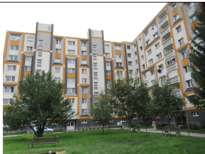
Pohľad zadný (od vchodu)
