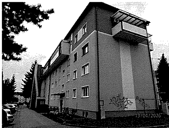
Pohľad na bytový dom zo severnej strany
