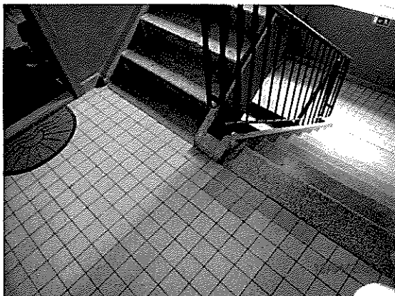
Schodisko a chodba pred bytom na 1 pos.
