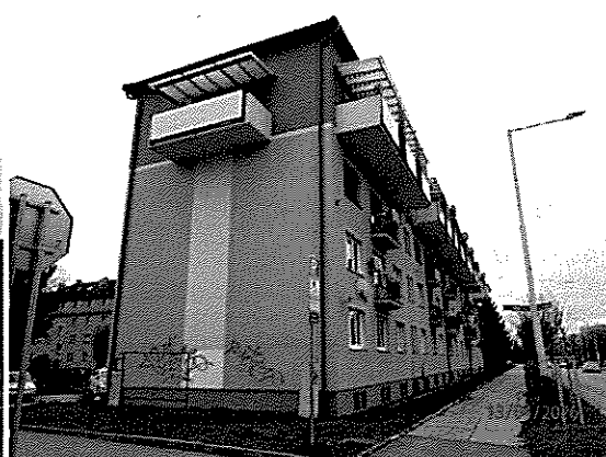
Pohľad na bytový dom zo SZ strany
