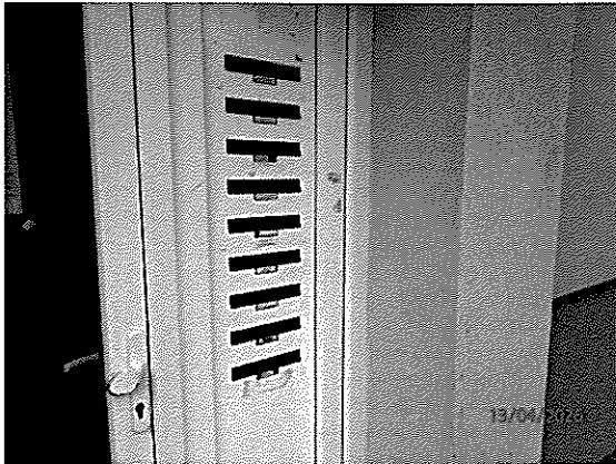
Vstupné dvere do vchodu č. 170
