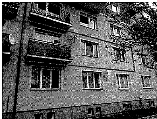
Okná bytu č. 4 na západnej fasáde domu
