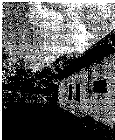
Foto č. 2 Pohľad na RD bočný
