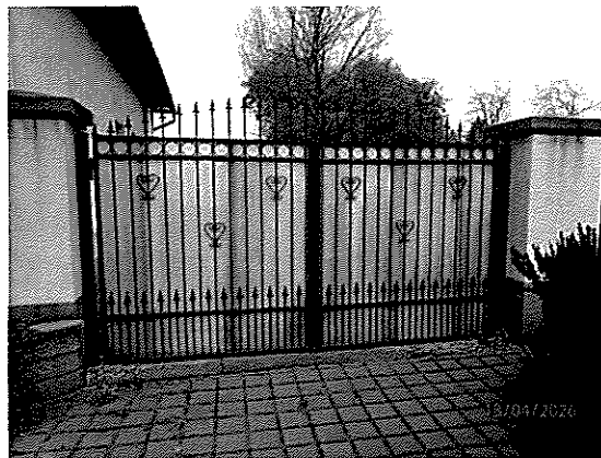
Vstupná brána do dvora od ulice
