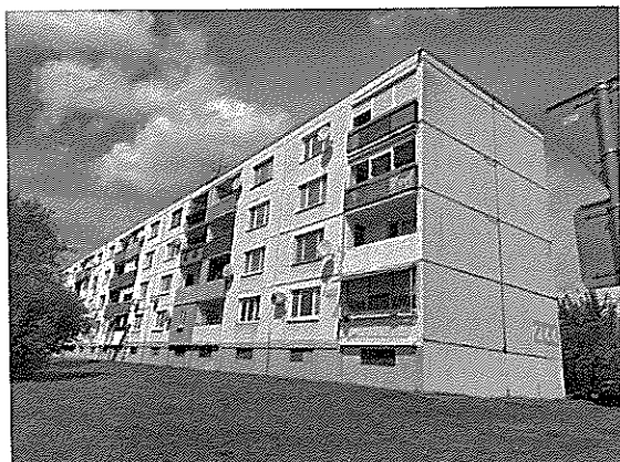
Pohľad na bytový dom z južnej strany
