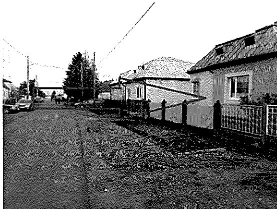
Ulica pred domom v smere na východ
