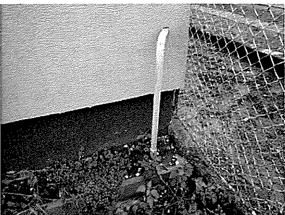
Zaústenie prípojky plynu do domu
