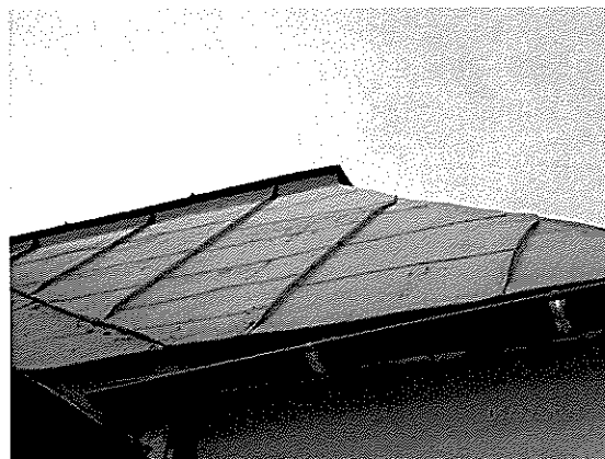
Pôvodná krytina na dome
