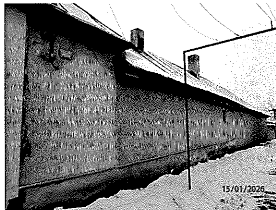
Zadná časť domu od suseda
