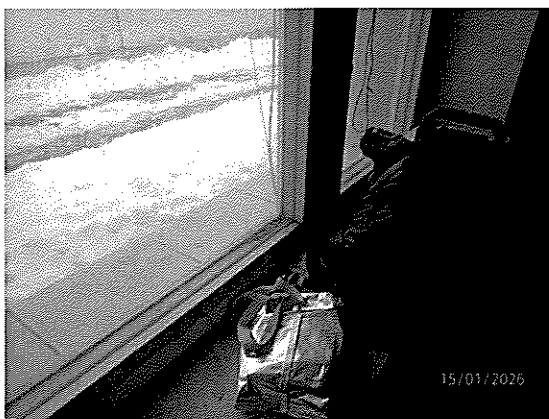
Pôvodné okno strednej izby
