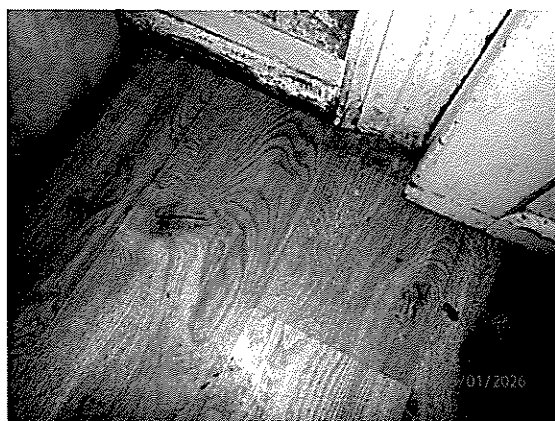
Detail podlahy strednej izby
