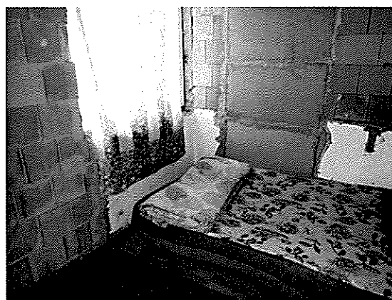
Predsieň – veranda na I.NP bez vstupu z dvora
